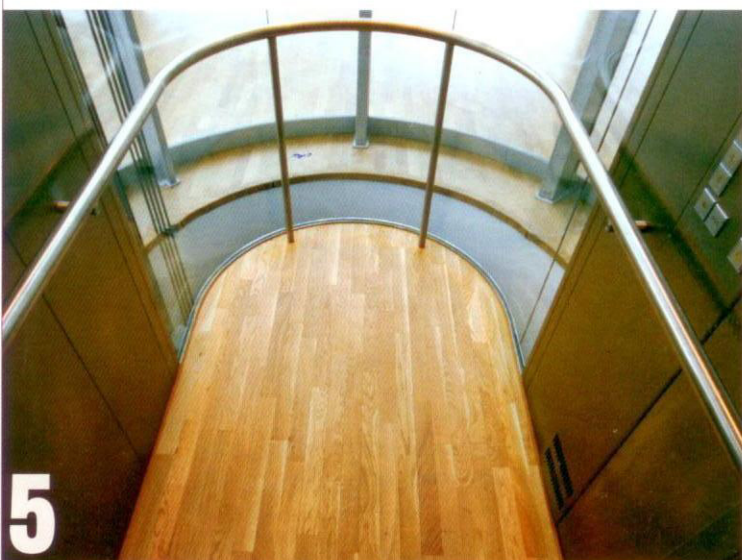
NIEPALNE PARKIETY ZAMOCOWANO RÓWNIEŻ W WINDACH.
